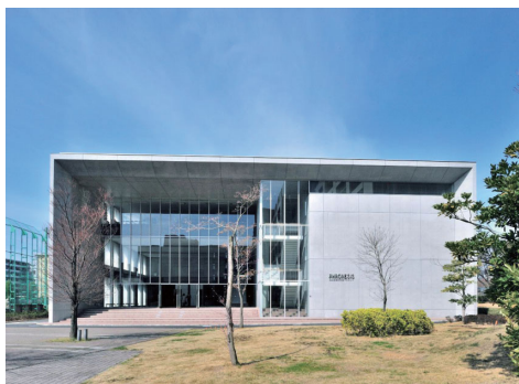
総合教育研究棟「フロネシス」
